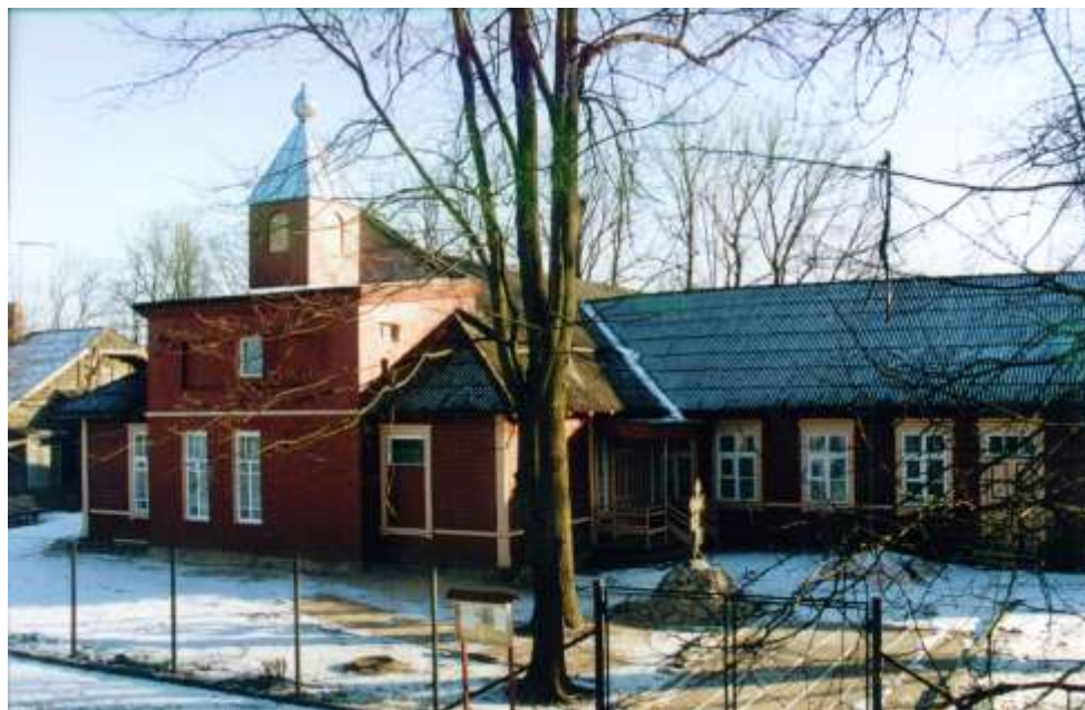
Внешний вид храма после реконструкции
